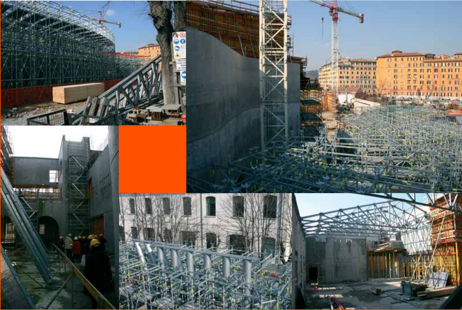
Visita al cantiere del MAXXI di Roma (progetto di Z. Hadid), coordinata da Margherita Guccione (direttore DARC) Visite au chantier du MAXXI de Rome (projet de Z. Hadid), coordonnée par Margherita Guccione (directeur DARC)
